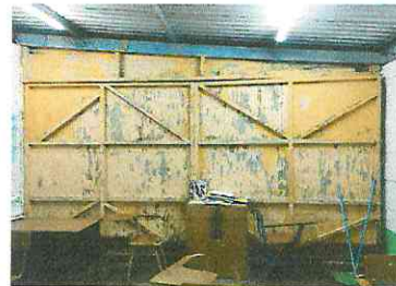
Foto 4: Aula 4. Cerramiento de división de aula con muros y pared de tablayeso 6x4 mt. Sustitución de alumbrado de aula por bombilla tipo led ahorradora de 55 w.
