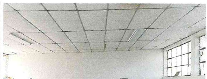
Foto 6: Aula 6. Sustitución de alumbrado de aula por bombilla tipo led ahorradora de 55 w.
