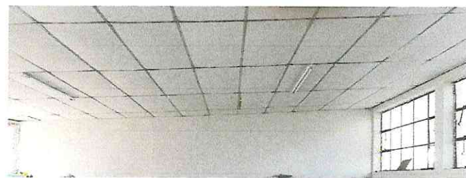
Foto 5: Aula 5. Sustitución de alumbrado de aula por bombilla tipo led ahorradora de 55 w.
