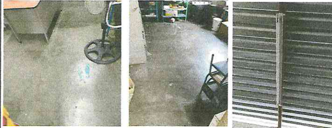
Foto 1: Aula 1. Sustitución de piso de cemento por piso ceramico de 1cm de espesor. Sustitución de alumbrado de aula por bombilla tipo led ahorradora de 55 w.
